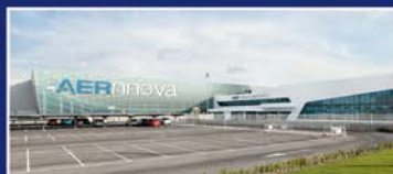
Nave industrial y oficinas para Aernnova en Illescas (Toledo).
